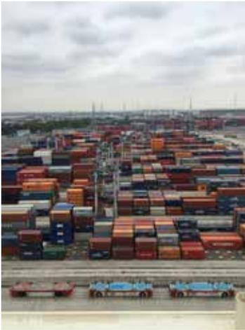
こんにちは。名古屋本社外勤営業の日比野です。普段は東海地方や西日本を中心にお客様を訪問しておりますが、今回は弊社のお客様である大手工作機械メーカー様からのご要望により、名古屋港にある飛島コンテナ埠頭(TCB)の見学に行ってきました。弊社と取引がある船会社様に依頼をして、乗船見学と日本初となる自動化コンテナターミナルであるTCBの見学をさせていただきました。TCBは大型ガントリークレーン6基、移動式ガントリークレーン(オペレーターによる遠隔操作をしています)で24基、AGV(ターミナル運行管理システムから無線通信により自動制御されている無人のコンテナ搬送用台車)33台を保有する国内でも最先端のターミナルとなりますが、なかでもAGV(写真)にはビックリさせられました。今から出港する船に積むコンテナ、到着した船から降ろしたコンテナをターミナル内で移動させる台車の様な車が、音楽を流しながら、無駄のない動きで動き回っております。また、乗船見学は欧州に向かう大型船(20'DRYコンテナに換算すると約10,000本)の中に入り込み、ガントリークレーンでドライコンテナを積み込むところや
