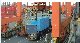
1 船側吊り上げ前
